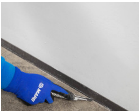
Ad indurimento della stuccatura, rifilare il bordo perimetrale tagliando la parte eccedente di Mapesonic Strip
