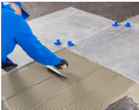
Su supporto adeguatamente preparato, procedere alla stesura dell'adesivo per l'incollaggio dei teli fonoisolanti
