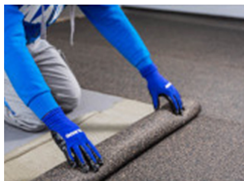
Distendere i rotoli di Mapesonic CR lungo le superfici interessate avendo cura di accostare perfettamente i teli l'uno all'altro
