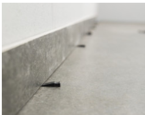
Applicare la zoccolatura perimetrale facendo in modo che non vi sia diretto contatto con la pavimentazione
